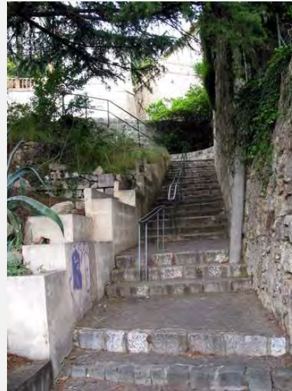
Les traverses de Grasse – Source : Egis
