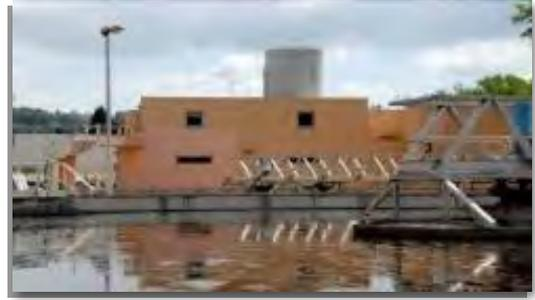
Cette usine a été construite et mise en service dans les années 80 et a connu ensuite dans les années 90 et 2010 différentes modifications permettant de s'adapter aux nouvelles réglementations et d'anticiper les évolutions de population. Elle a une capacité de 52 000 équivalents habitants et un débit de référence de 10 200 m<sup>3</sup>/j.
