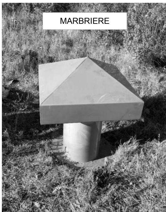
Photos cheminées d'aérations des réservoirs
