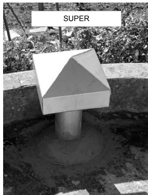
Photos cheminées d'aérations des réservoirs
