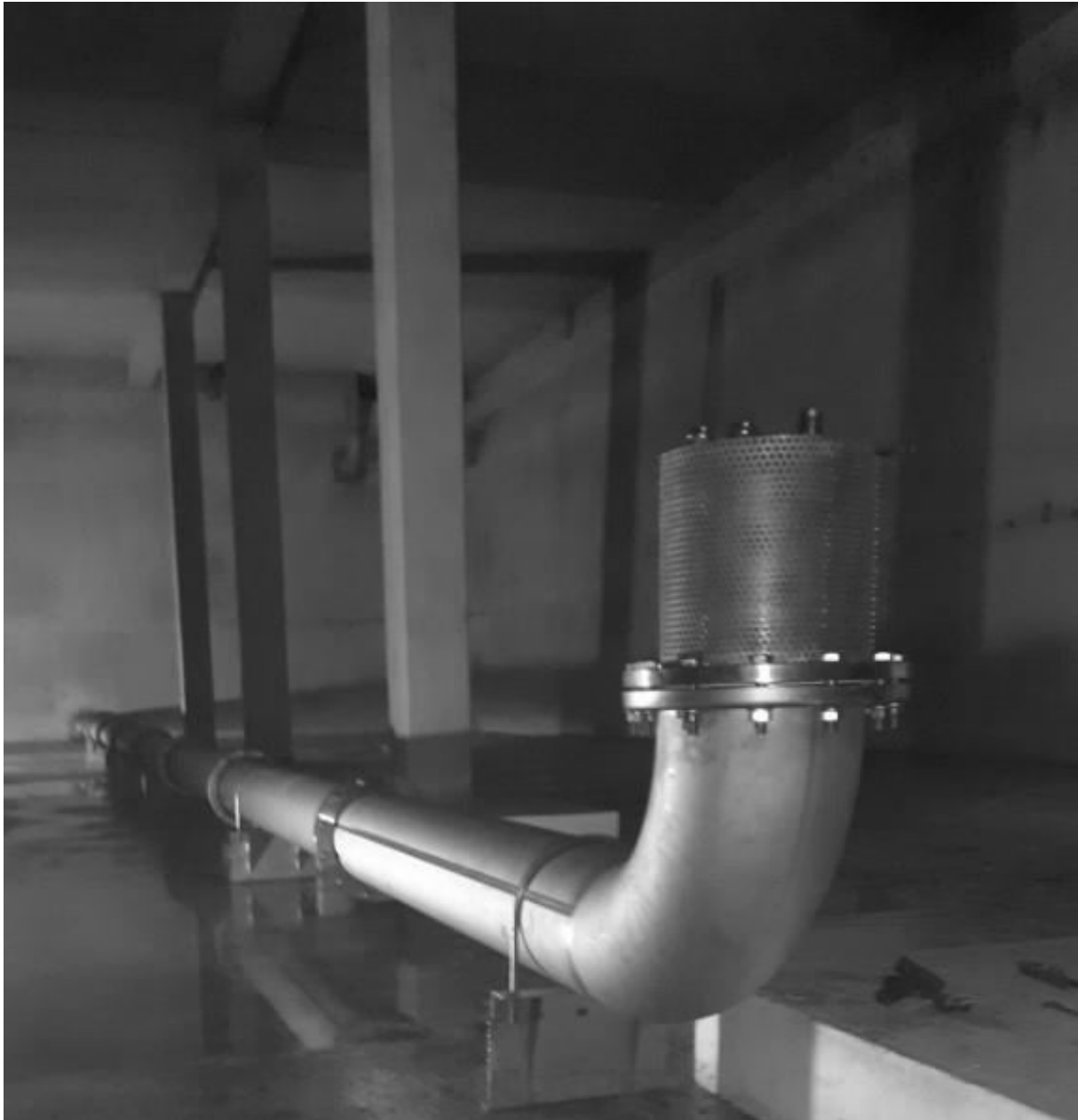
Photo de la canalisation après remplacement
