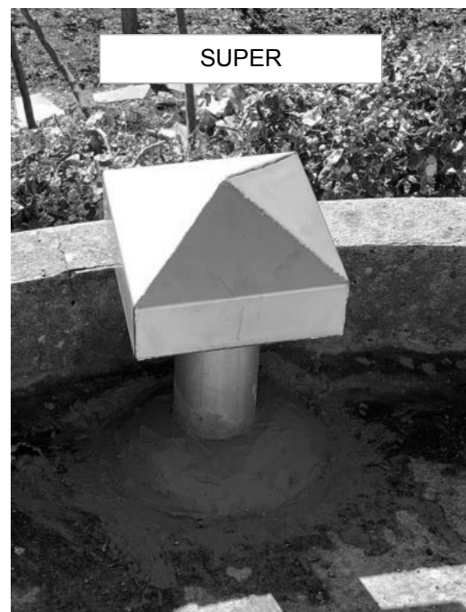
Photos cheminées d'aérations des réservoirs
