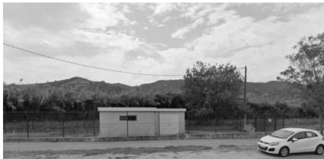
Poste de relèvement de Bastidon
