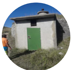
Réservoir de La Sagne (60 m³)
