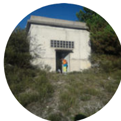
Réservoir Ste Anne (300 m³)
