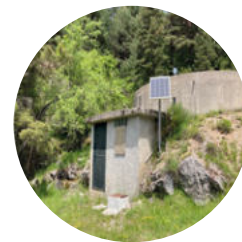
Réservoir Les Amphons (150 m³)
