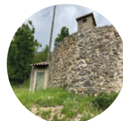
Réservoir Haut Village (100 m³)
