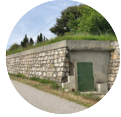
Réservoir Sambuc (100 m 3 )
