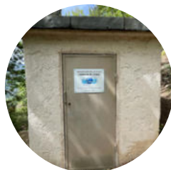
Réservoir de la Clue (35 m³)
