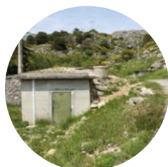
Réservoir Les Galants (100 m³)
