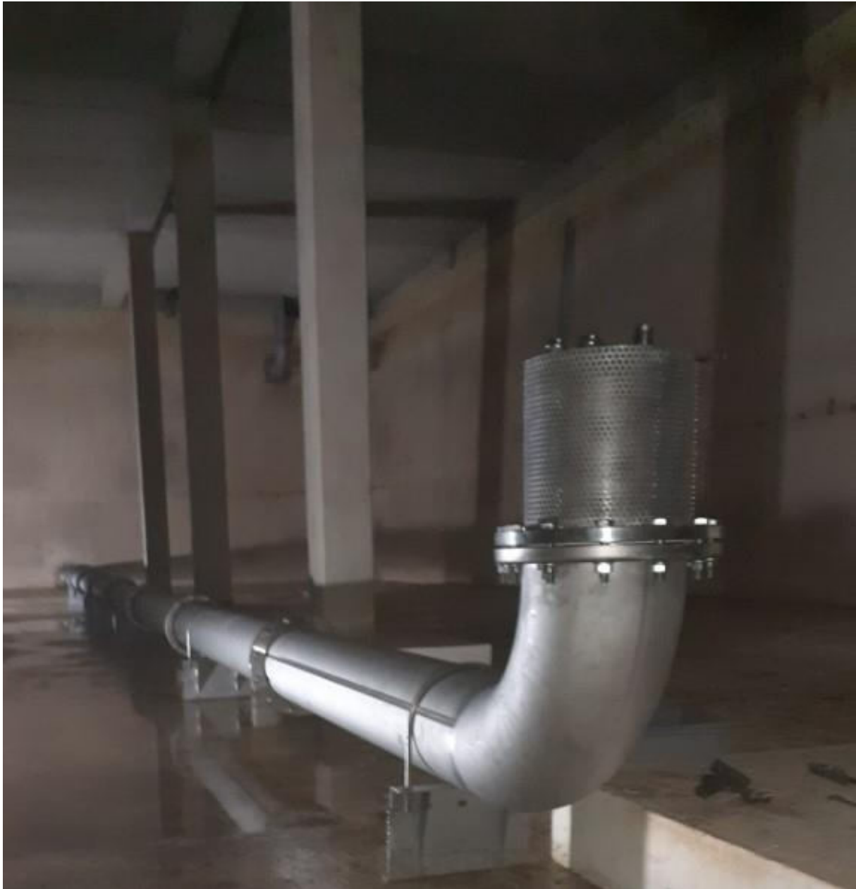
Photo de la canalisation après remplacement
