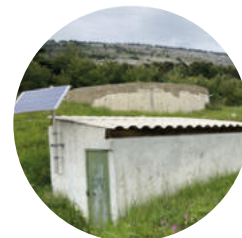
Réservoir Le Bail (150 m³)
