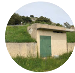
Réservoir Grand bassin (150 m 3 )
