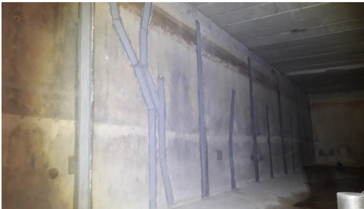
Photos du traitement des fissures visibles ainsi que les traversées de paroi des canalisations
