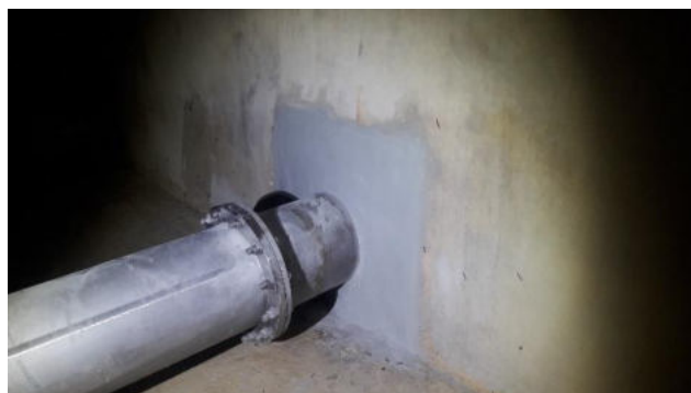
Photos du traitement des fissures visibles ainsi que les traversées de paroi des canalisations
