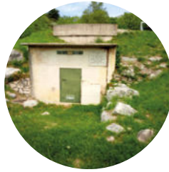
Réservoir Les Murlans (150 m 3 )
