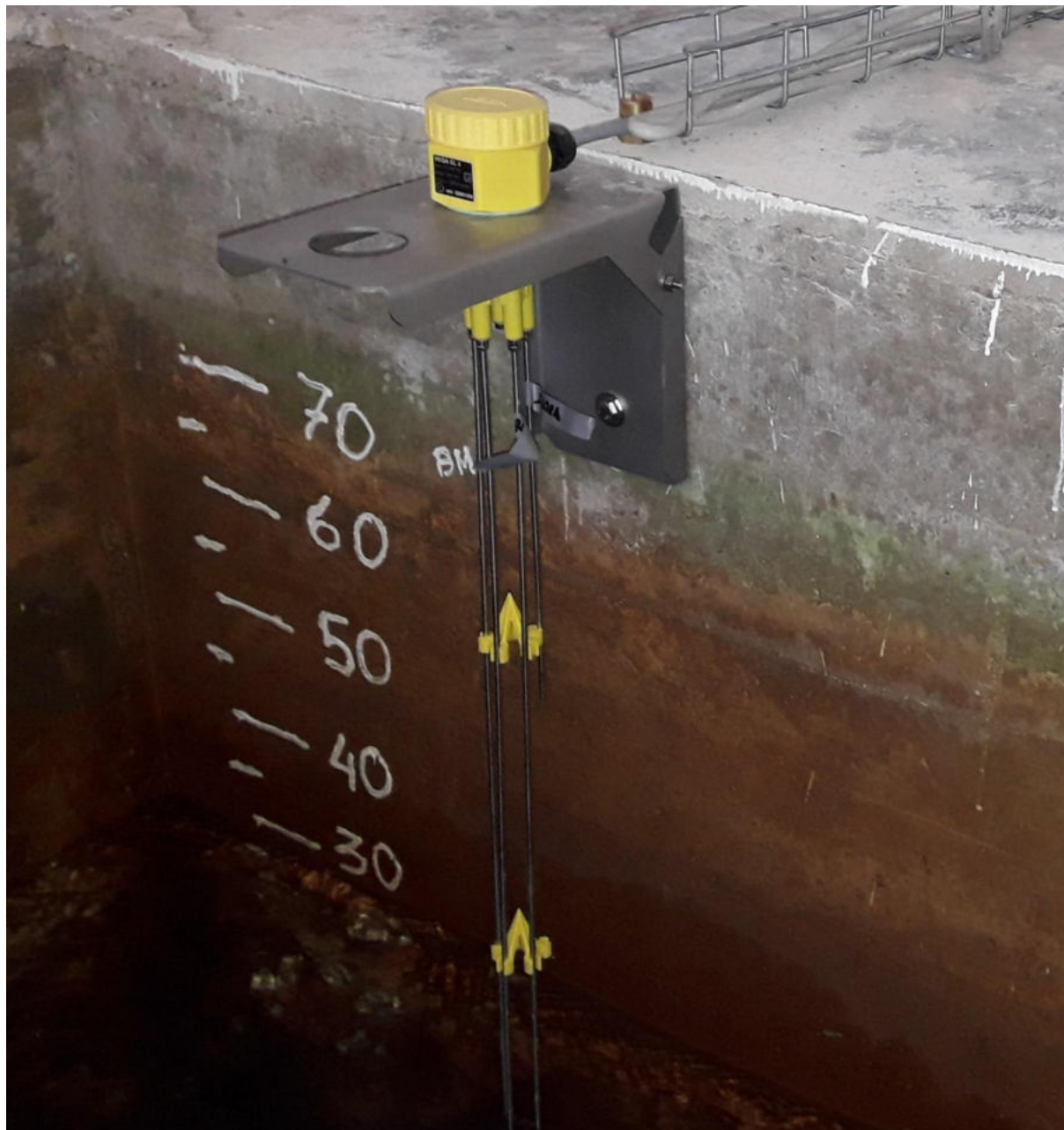
Photo de la sonde après mise en place
