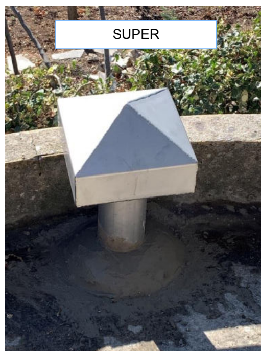
Photos cheminées d'aérations des réservoirs
