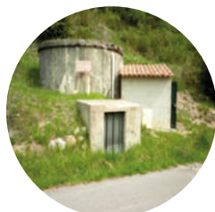
Réservoir Clars (30 m³)
