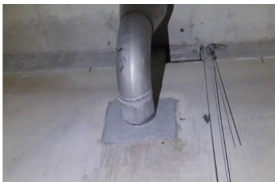
Photos du traitement des fissures visibles ainsi que les traversées de paroi des canalisations
