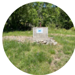
Réservoir Maupoil (20 m³)
