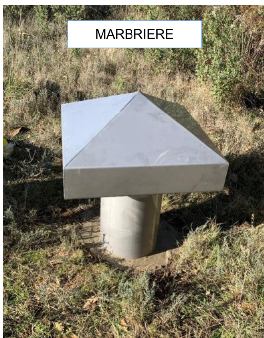
Photos cheminées d'aérations des réservoirs
