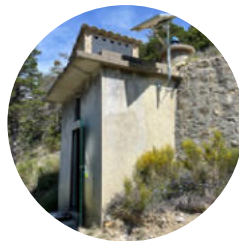
Réservoir Pied D'agou (100 m³)
