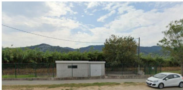
Poste de relèvement de Bastidon
