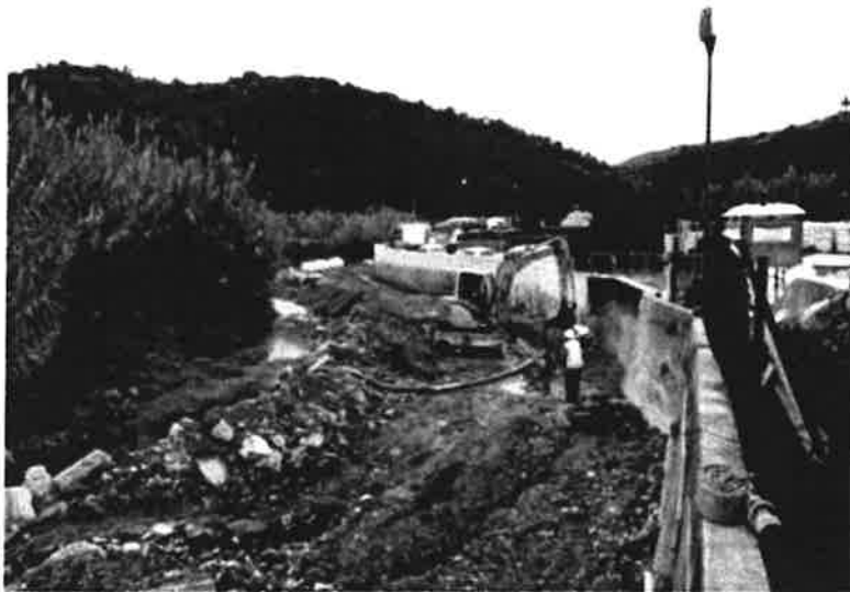
Réparation du mur de la traverse des Cannebiers sur la Frayère à Auribeau – Octobre 2013
