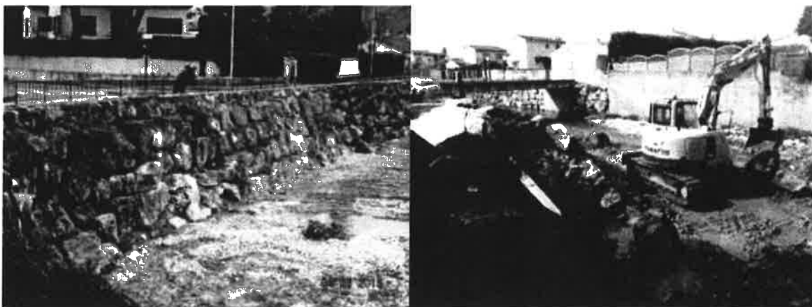
Réparation d'enrochements sur la Mourachonne à Pégomas
