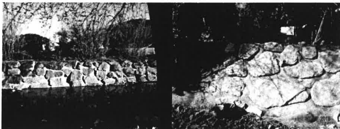
Réparation d'énrochements à Auribeau sur Siagne
