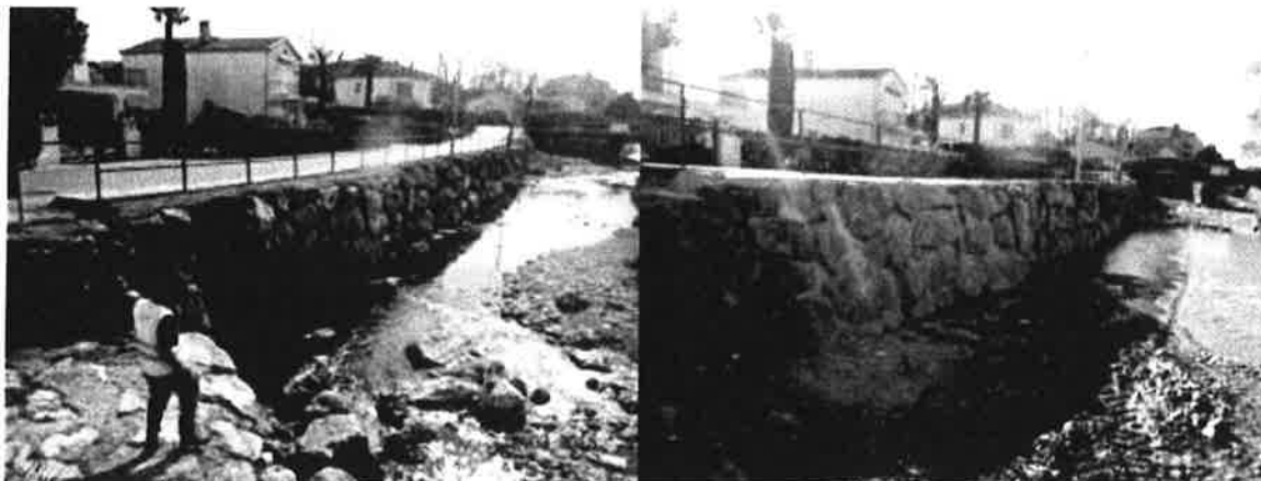
Réparation d'énrochements au Plan de Grasse
